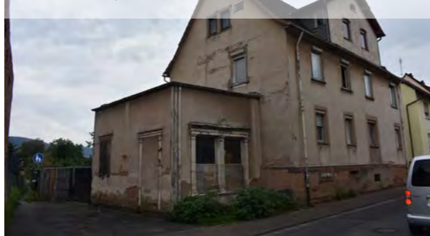
Foto: Substanzmängel an einem Gebäude II © Salm & Stegen 2023
